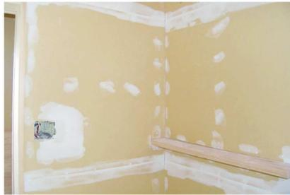
スーパーガニックSは目地処理、下地処理材です。目地用、下地用、汎用タイプがございますので用途にあわせてご使用下さい。白セメントを主成分とし、無機イオン化合物を添加する事で結晶を安定化させた無機系の下地処理材です。塗布後、乾燥時間が早いので次の作業に素早くとりかかる事ができます。スーパーガニックS(汎用)は、漆喰や珪藻土などの塗り壁用です。塗り壁を施工する場合は、こちらの汎用で目地処理と下地処理の兼用可能です。
